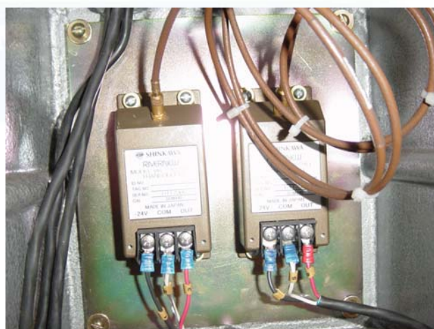
Driver de interligação entre os sensores e o indicador
