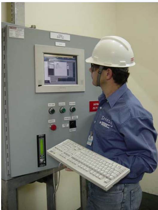
Monitor de vibração modelo V5 montado em painel localizado na sala de controle. Instalação remota
