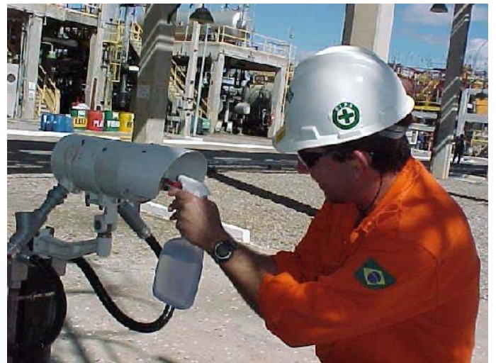
Verificação e manutenção preditiva nos detectores modelo IR5000
