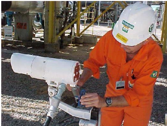
Verificação e manutenção preditiva nos detectores modelo IR5000
