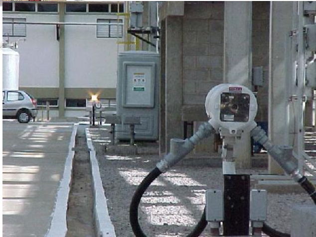
Detector de gás combustível em feixe aberto modelo IR5000. Detalhes de instalação
