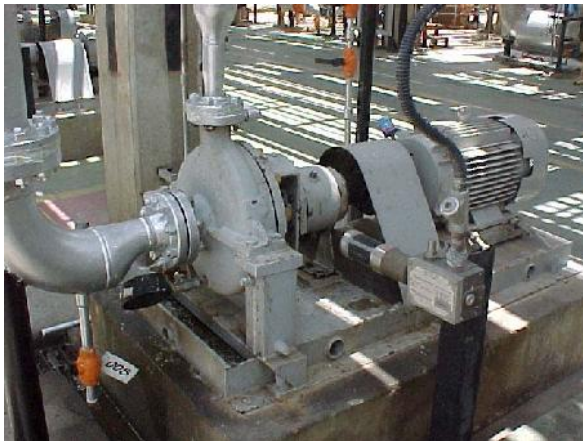
Detector pontual por infravermelho modelo IR2100 instalados nas áreas de processo
