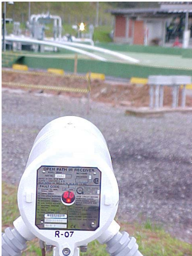
Instalação e start-up dos detectores de gás combustível em feixe aberto modelo IR5000
