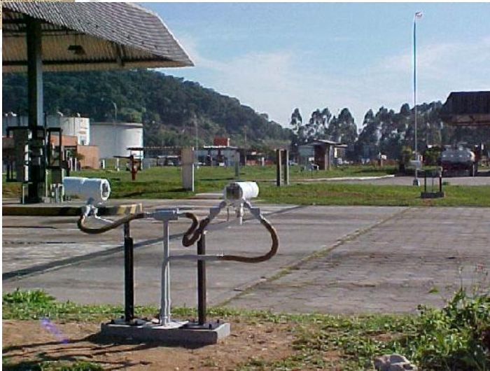
Detector de gás combustível em feixe aberto modelo IR5000. Instalação nas áreas de processo
