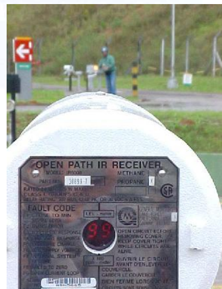
Instalação e start-up dos detectores de gás combustível em feixe aberto modelo IR5000
