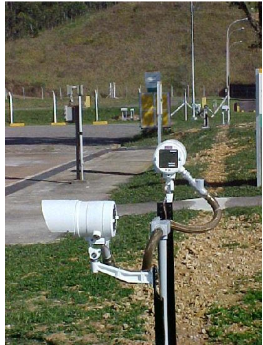
Detector de gás combustível em feixe aberto modelo IR5000. Instalação nas áreas de processo
