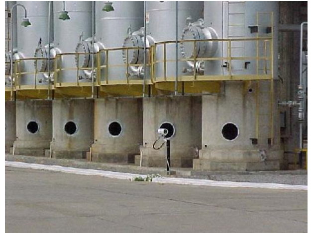
Detector de gás combustível em feixe aberto modelo IR5000. Detalhes de instalação
