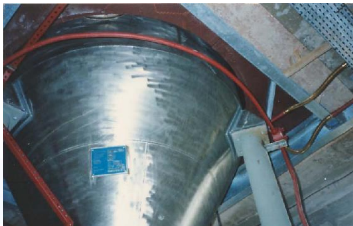
Vista do Tanque
