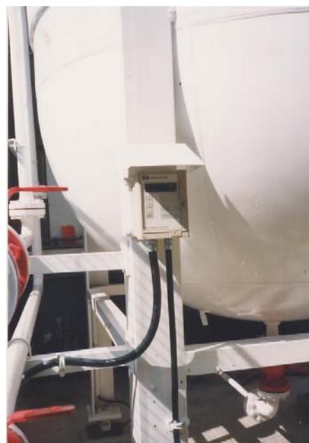
Indicador Digital. Controle efetuado remotamente via modem
