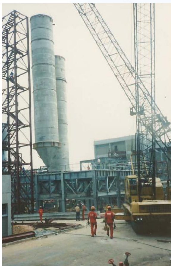
Momento de assentamento dos silos
