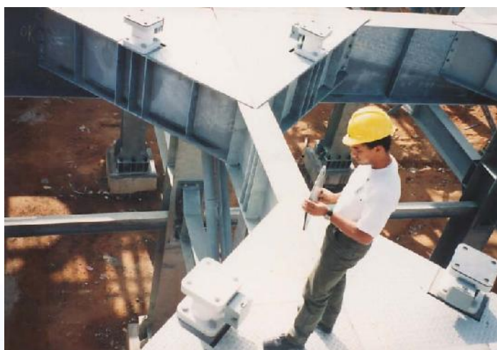
Vista dos sensores antes do assentamento dos silos
