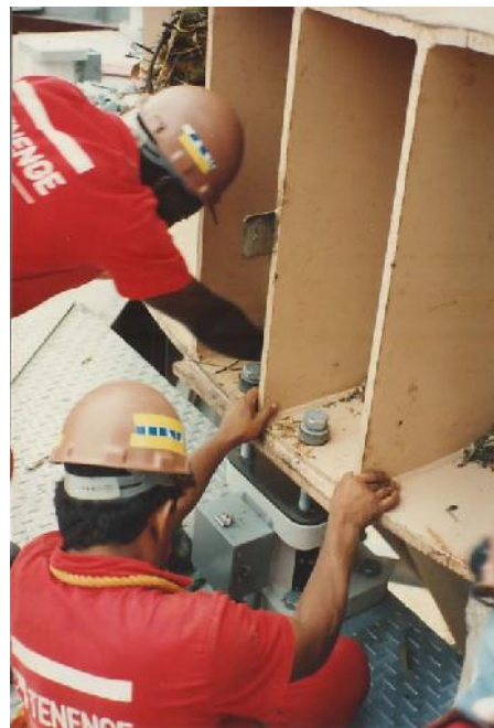
Detalhe de fixação dos sensores se tornando parte integral da estrutura
