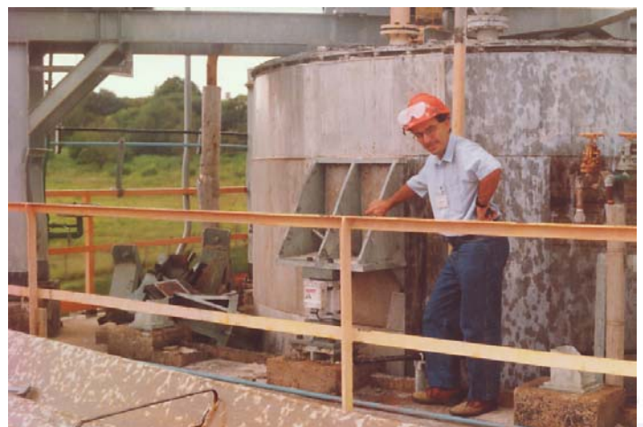
Montagem final do sistema de pesagem Remoção total dos travamentos iniciais
