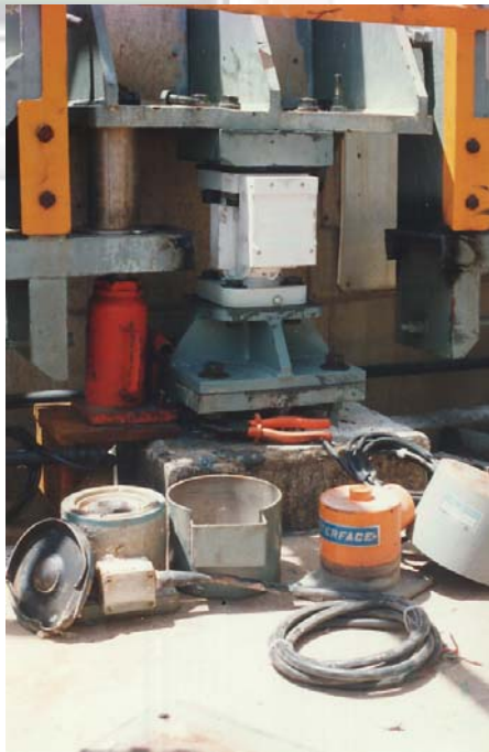
Substituição dos sensores
