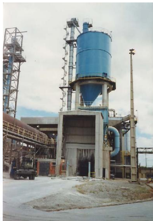
Vista Geral do Silo
