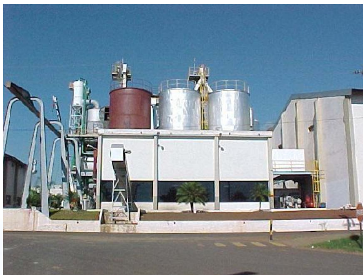
Vista Geral dos Silos
