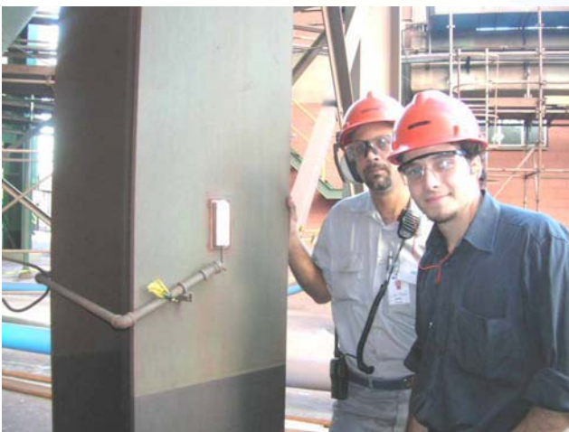
Detalhe de instalação do sensor na viga de sustentação e do indicador Sem necessidade de modificação estrutural
