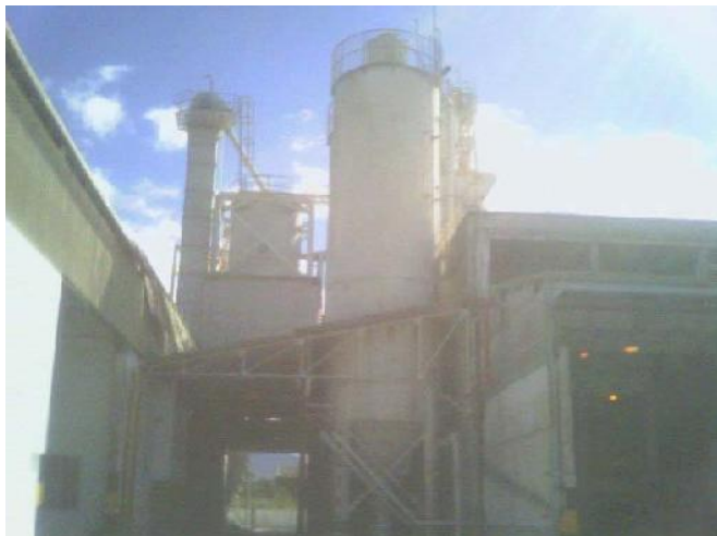
Vista Geral dos Silos
