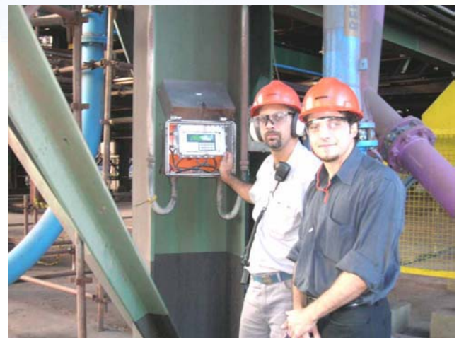
Detalhe de instalação do sensor na viga de sustentação e do indicador Sem necessidade de modificação estrutural
