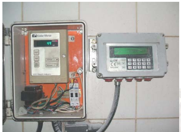
Montagem Remota dos Indicadores
