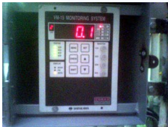
Monitor de vibração modelo VM-15 recebendo sinais dos sensores acelerômetros modelo AC-122
